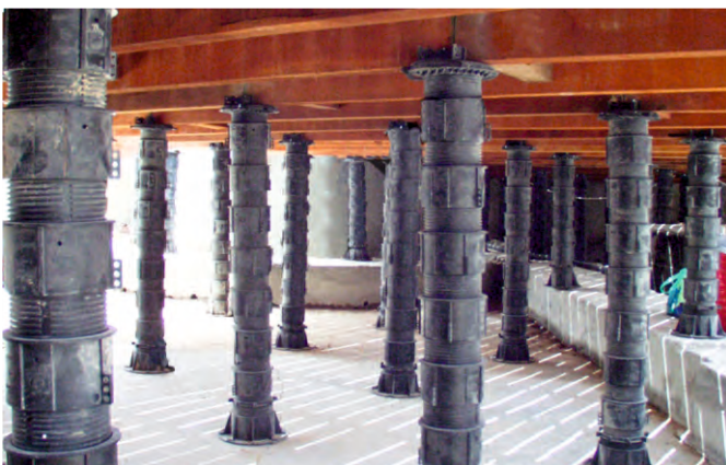
Строительство настилов на основаниях с большим перепадом высот.
