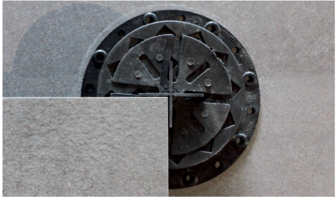
Расположение угла плитки на вершине регулируемой опоры.
