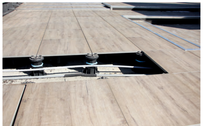
Строительство настилов и полов на эксплуатируемых кровлях.
