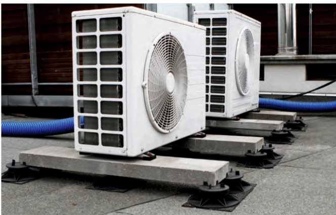
Установка оборудования в строго горизонтальном положении.
