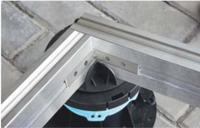
Размещение конструкции из алюминиевых лаг на регулируемых опорах KRONEX.
