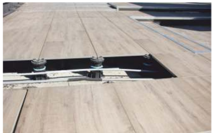
Строительство настилов и полов на эксплуатируемых кровлях.
