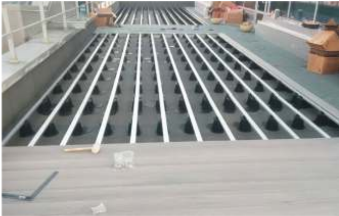
Строительство полов террас, беседок, временных настилов из ДПК.
