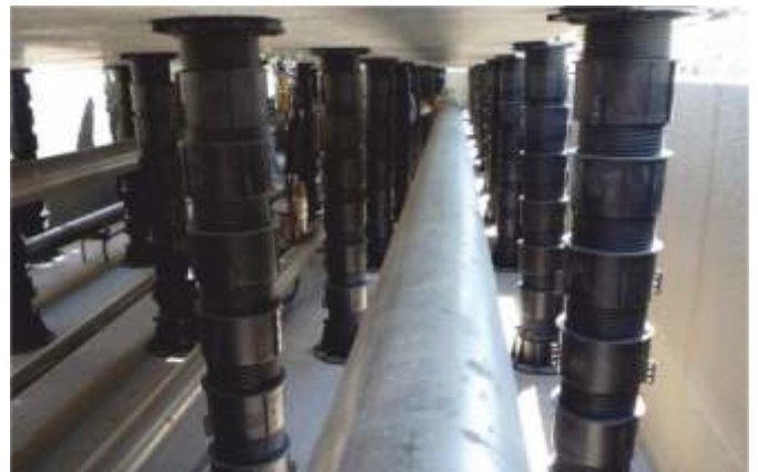
Прокладка коммуникаций под настилом с возможностью последующего доступа.
