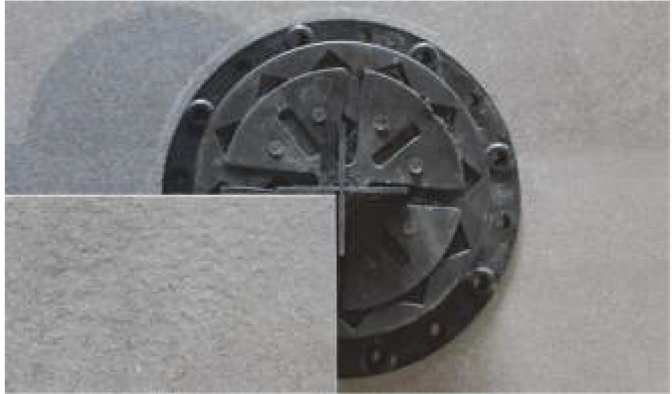
Расположение угла плитки на вершине регулируемой опоры.
